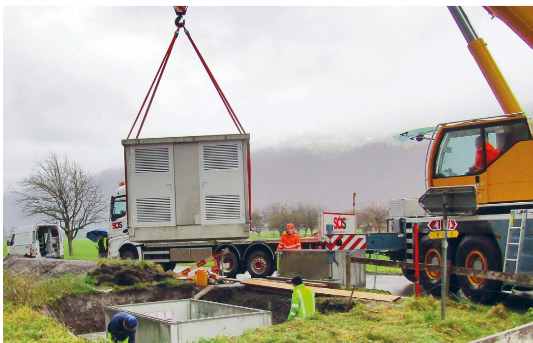
Ersatz Trafostation Stadtnerriet
