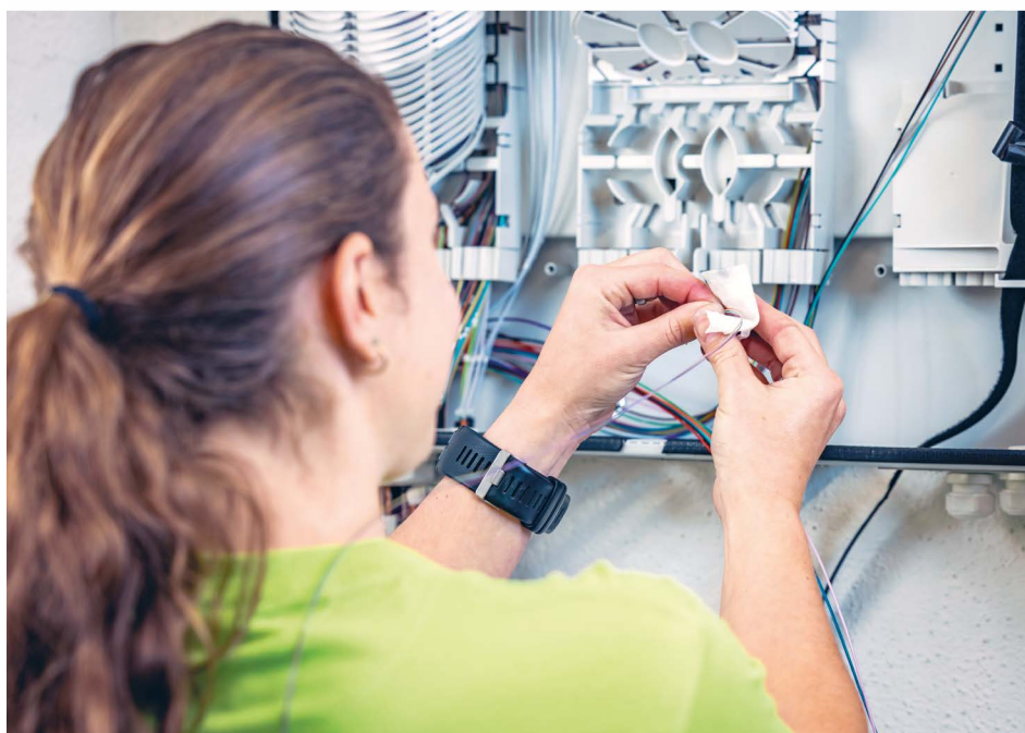
Reinigung der Glasfasern vor Spleissung
