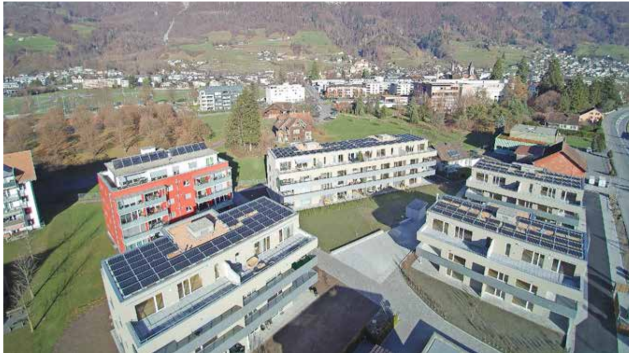
Experiment, das vielerorts Interesse weckt: Das Quartier Schwemmiweg in Walenstadt ist zurzeit ein Labor der Energiezukunft. Pressebild
