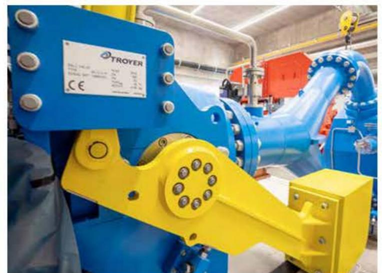
«Der Kugelschieber am unteren Ende der Druckleitung»
