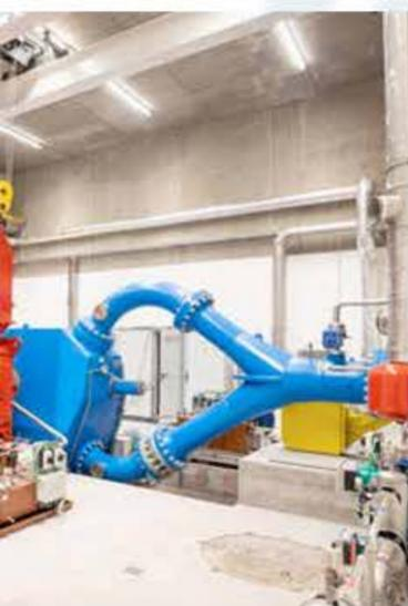
«Der Generator mit der zweidüsigen Pelton-turbine»
