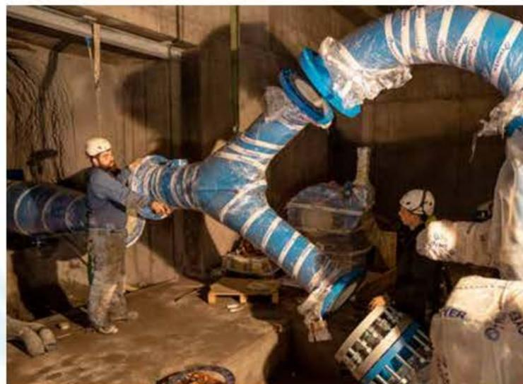
«Einbau des Verzweigers auf die beiden Düsen der Peltonturbine»
