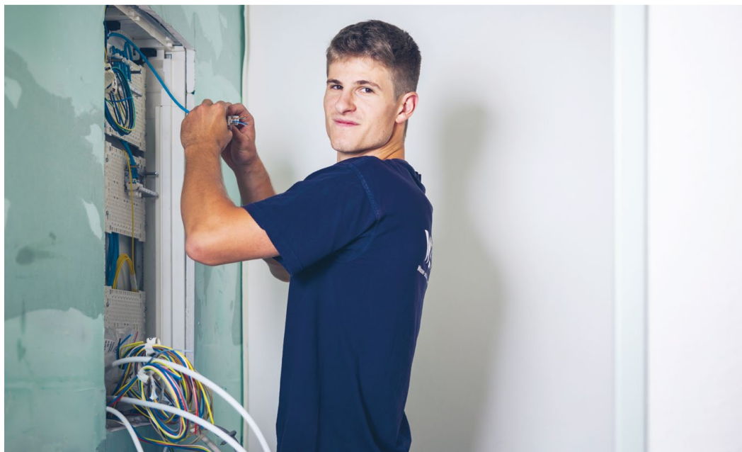
Oehy Kim Elektroinstallateur
