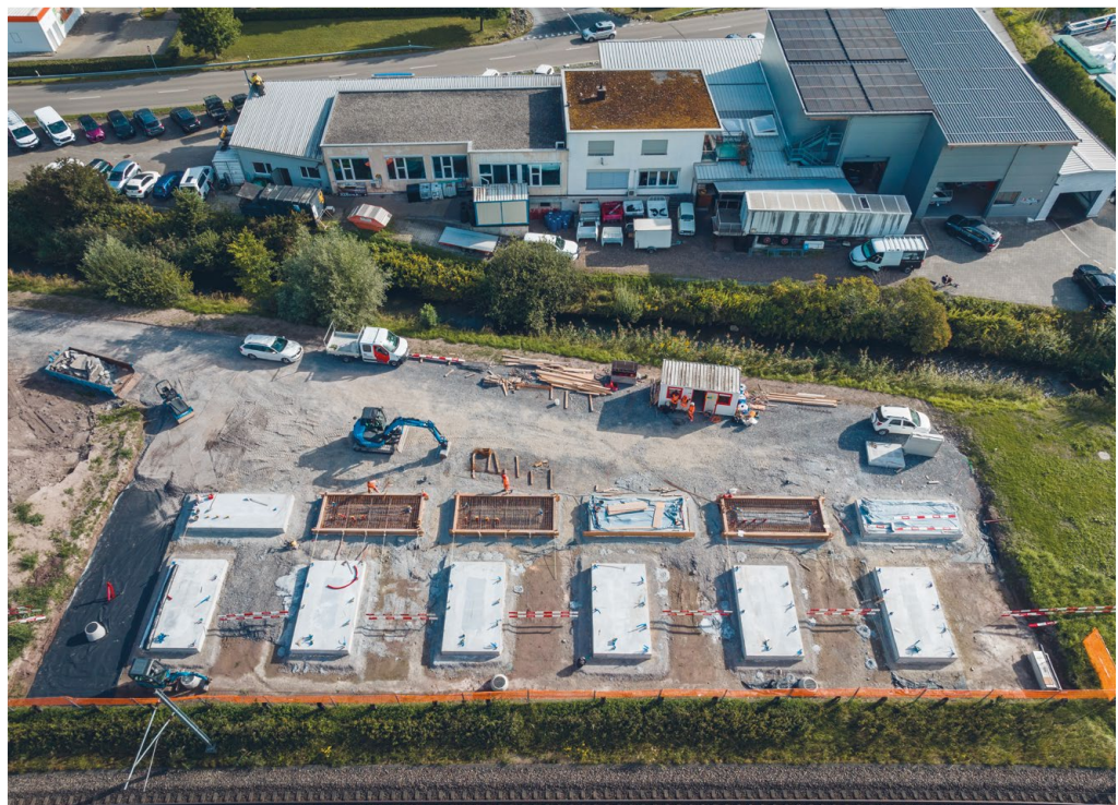
Bauplatz für die drei Grossbatterie-speichersysteme
