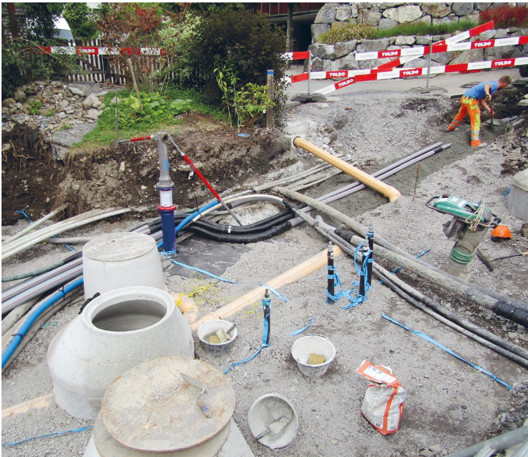
Sanierung Alte Dorfgrasse
