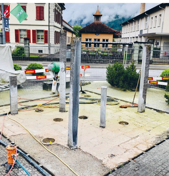
Sanierung Wasserspiel Bahnhofstrasse
