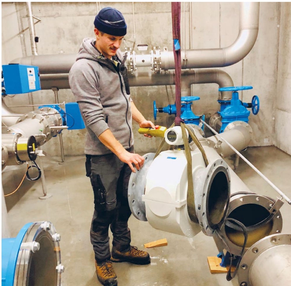
Ausbau Wassermesser, Kraftwerk Töbeli, Kim Oehy, Rohrnetzmonteur
