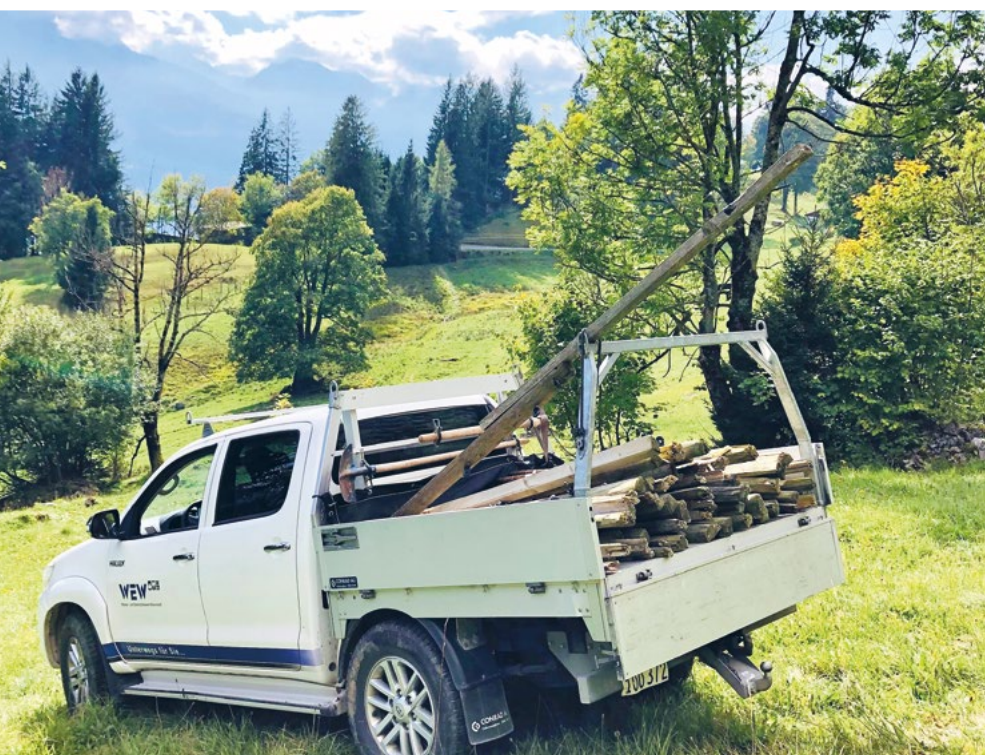
Rückbau Quellschutzzone, Schrina
