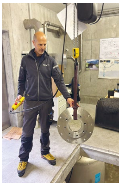
Einbau eines Reduzierflanschs, Bernhard Oehy, Brunnenmeister
