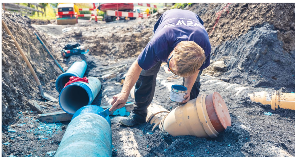
Ersatz Hydrantenleitung Dorfhaldenstrasse
