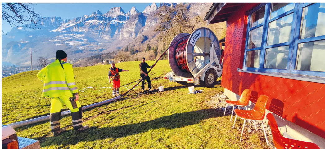
Kabelzug neues MS-Kabel «Gnols»
